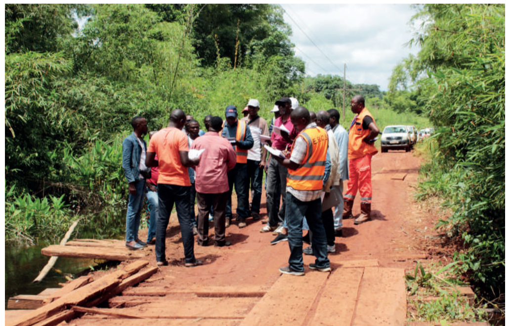
Implantation des travaux
