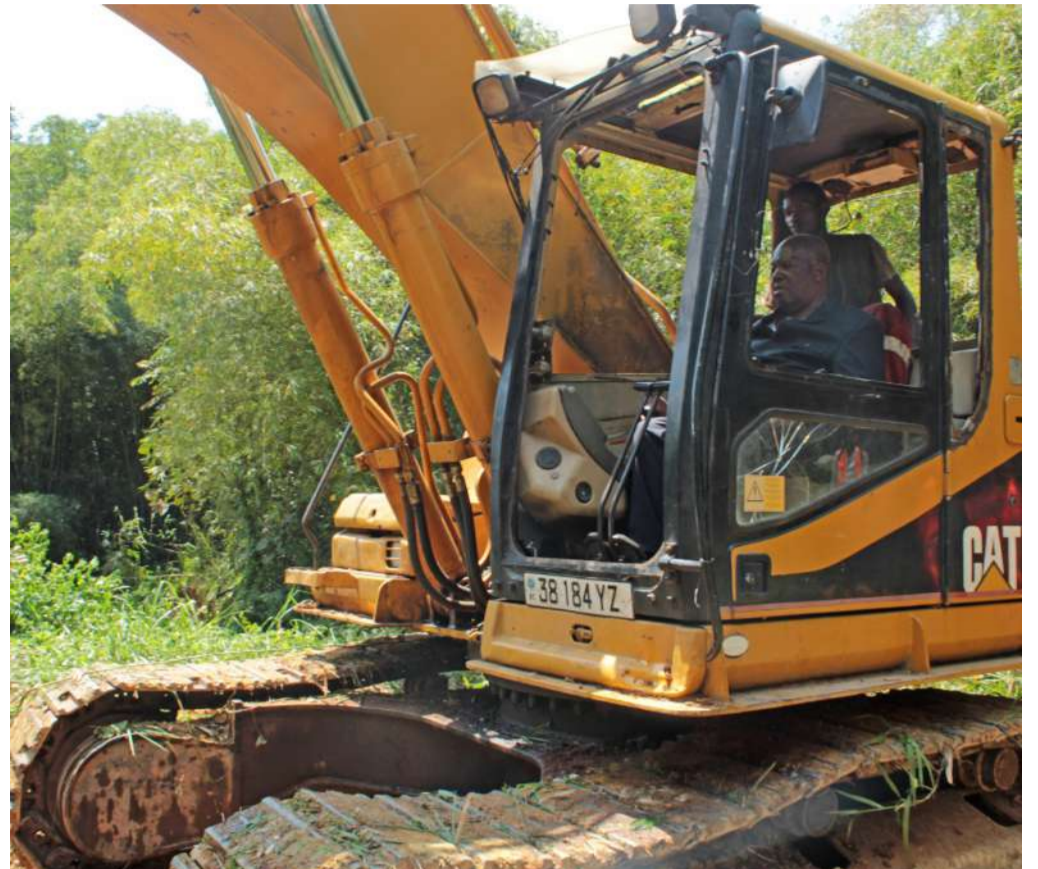
Jacques ONGOTTO lançant les travaux
